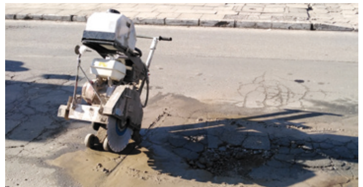
Remonty ubytków drogowych prowadzone są przez ZUWiK w Siewierzu.
