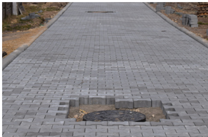
Nowe drogi na Piwoni w Siewierzu zostały wykonane z kostki brukowej.
