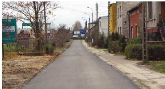
Nowa nakładka asfaltowa na ulicy Warszawskiej
