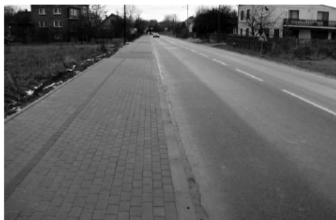
Wybudowana ścieżka pieszo-rowerowa w ciągu drogi wojewódzkiej 793 w Leśniakach
