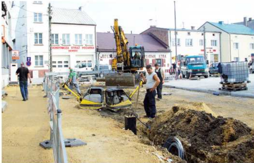
Prace budowlane przy modernizacji siewierskiego rynku - jednej z licznych inwestycji tego lata
