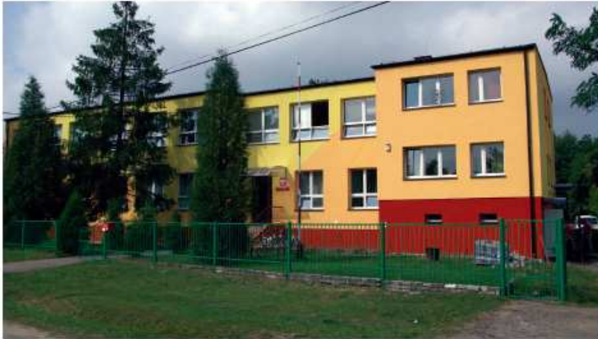
Szkoła Podstawowa Nr 2 w Siewierzu po termomodernizacji
