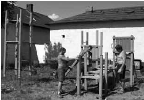
Montaż placu zabaw przy ulicy Mostowej w Siewierzu
