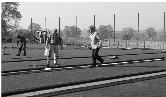
Prace wykończeniowe podczas układania sztucznej nawierzchni na boisku w Wojkowicach Kościelnych
