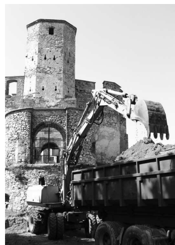
Prace przy budowie mostu zwodzonego na Zamku Siewierskim
