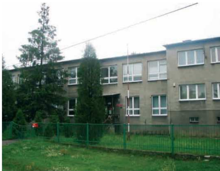
Szkoła Podstawowa Nr 2 w Siewierzu - Sulikowie przed termomodernizacją
