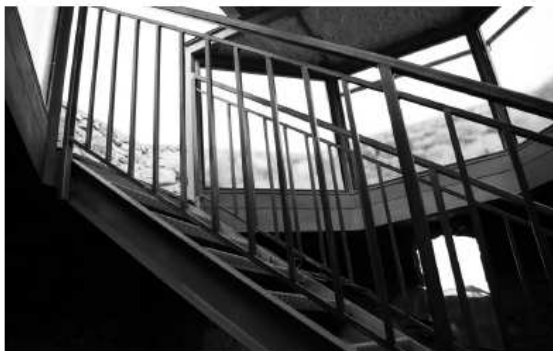
Klatka schodowa w wieży bramnej zamku i wejście na platformę widokową
