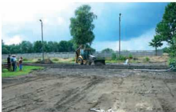
Budowa boiska wielofunkcyjnego przy Zespole Szkolno-Przedszkolnym w Żelisławicach
