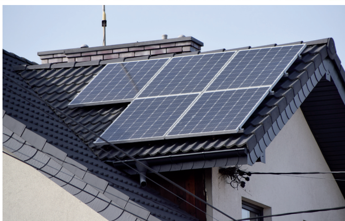
W ramach projektu zamontowano już ponad 250 instalacji fotowoltaicznych.
