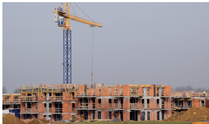
W ostatnim czasie rozpoczęto budowę siedmiu budynków wielorodzinnych.
