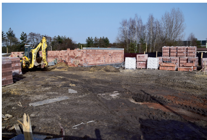
Na terenie inwestycji Wykonawca rozpoczął już budowę ścian budynku.
