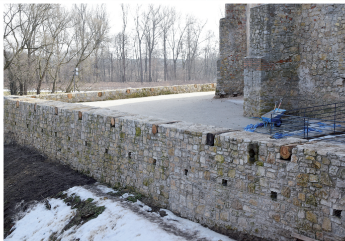
Posadzka tarasu artyleryjskiego została wykonana w systemie HanseGrand®
