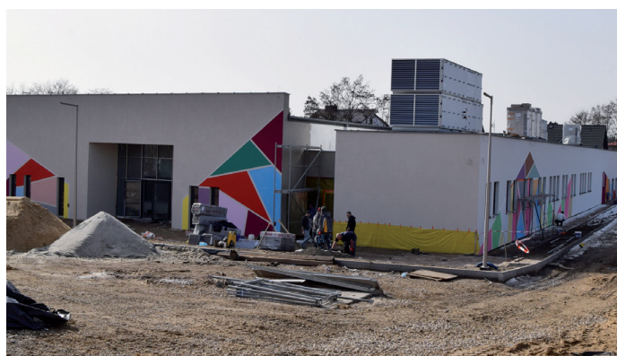
Na budynku żłobka kończą się prace związane z wykonaniem elewacji.
