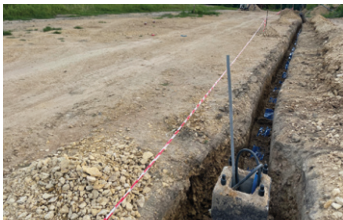
Na terenie inwestycji aktualnie prowadzone są prace elektryczne. drogowym na ulicy Chabrowej w Siewierzu.
