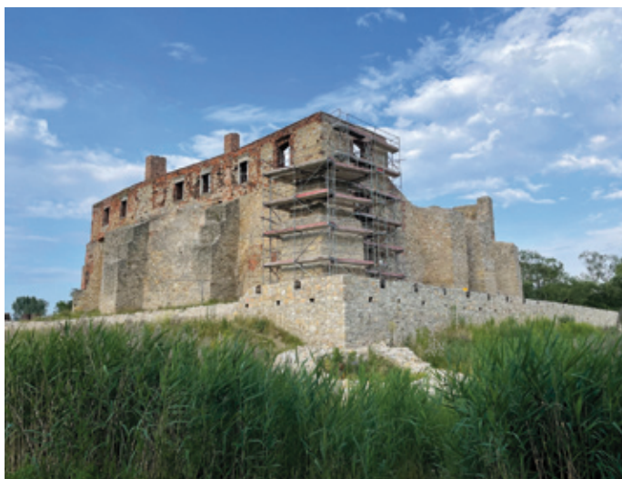
Prace renowacyjne obejmują zabezpieczenie zamkowych ścian i przypór.
