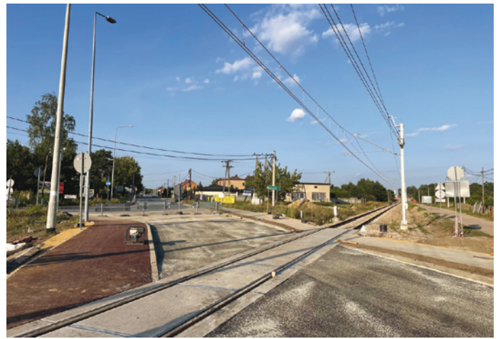
Wyremontowano przejazd kolejowy w ciągu ul. Żwirki i Wigury i Kieleckiej.
