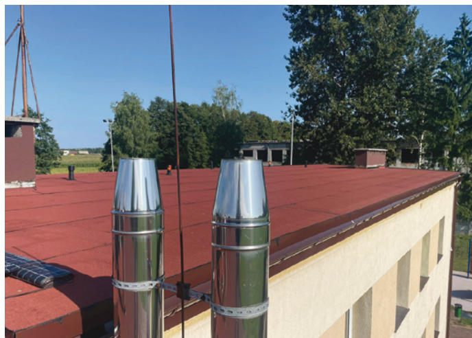
Podczas wakacji wykonano kompleksowy remont dachu na budynku szkoły.
