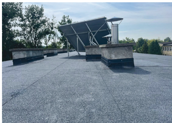
W ramach prac wykonano m.in. remont poszycia dachowego.
