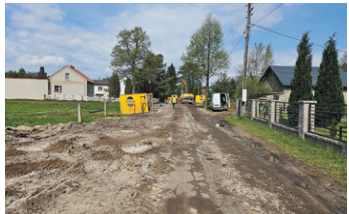
Na ul. Zawodzie w Wojkowicach Kościelnych trwają intensywne prace budowlane.
